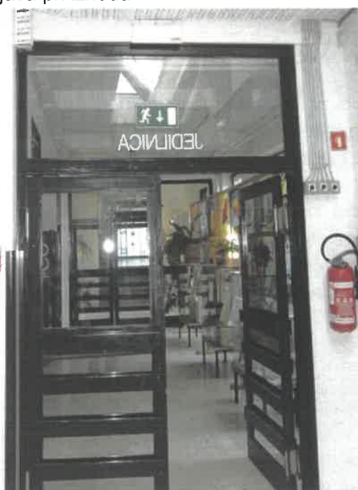
Slika 33: varnostna razsvetljava pri izhodu
