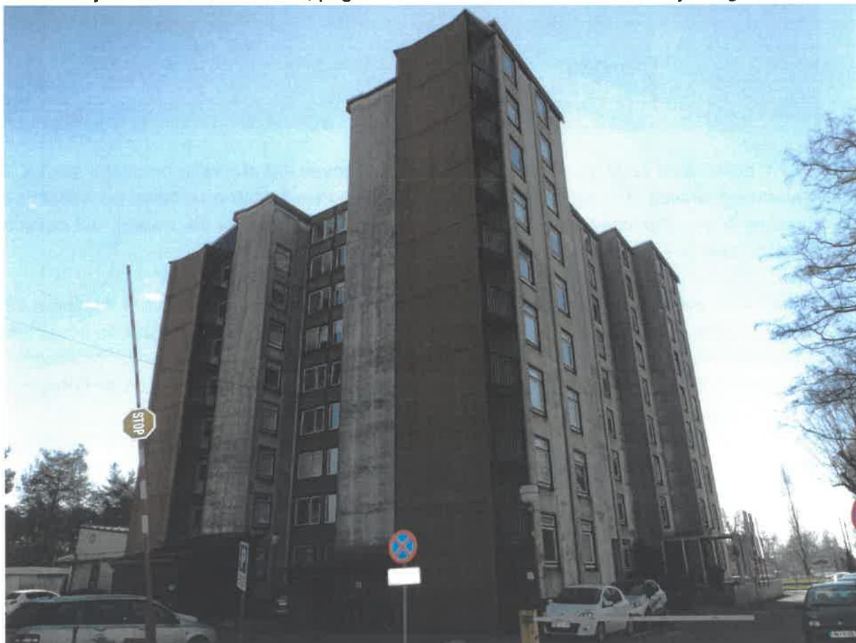
Slika 5: Dijaški dom Lizike Jančar, pogled na vzhodno in severno fasado dijaškega doma
